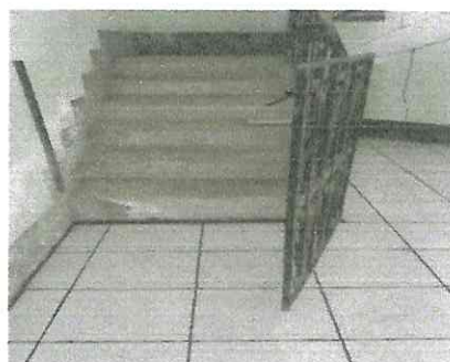
Foto 4: Instalar puerta de gradas
