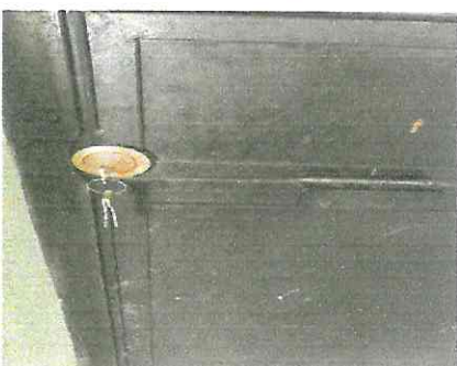
Foto 3: Cambio de chapa en cocina
