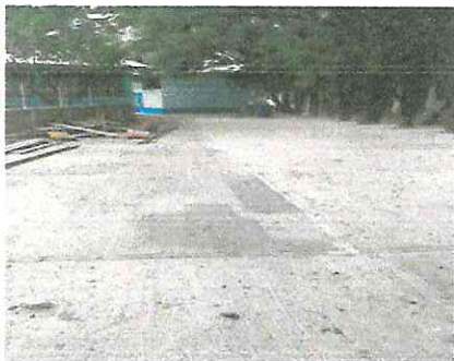
Foto1: Sustitucion de piso de tierra por piso de cemento
