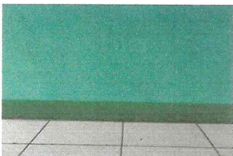
Foto 5: pintura de muro perimetral en cocina
